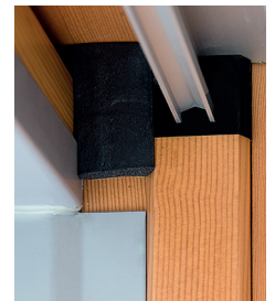
Schaubild: Einbau in einer Hebe-/Schiebetüre
