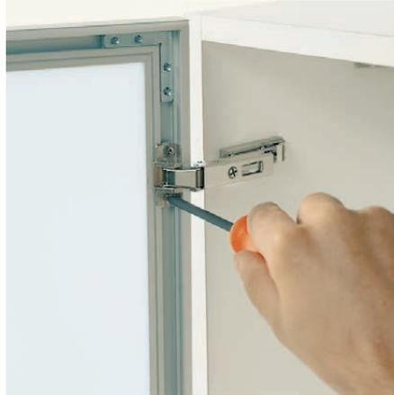
Die Bänder auf den Montageplatten befestigen und dann in den zusammengesetzten Rahmen einsetzen.
