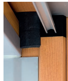
Schaubild: Einbau in einer Hebe-/Schiebetüre
