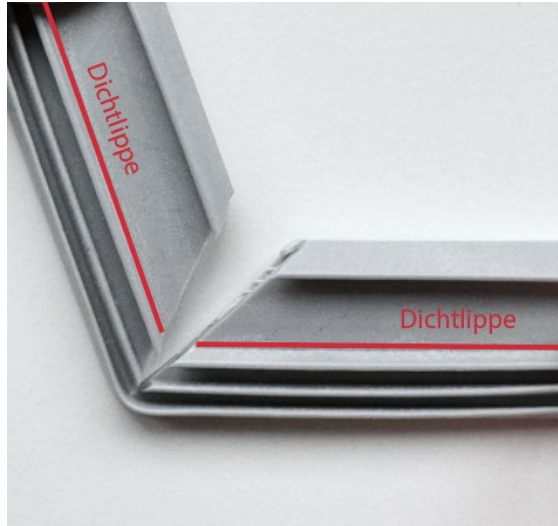
Dichtlippe für Rahmeneinbau wird hier durchtrennt
